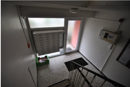
Briefkastenanlage mit Eingangsbereich
