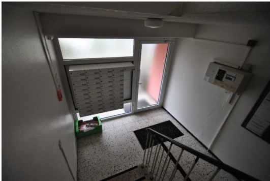
Briefkastenanlage mit Eingangsbereich
